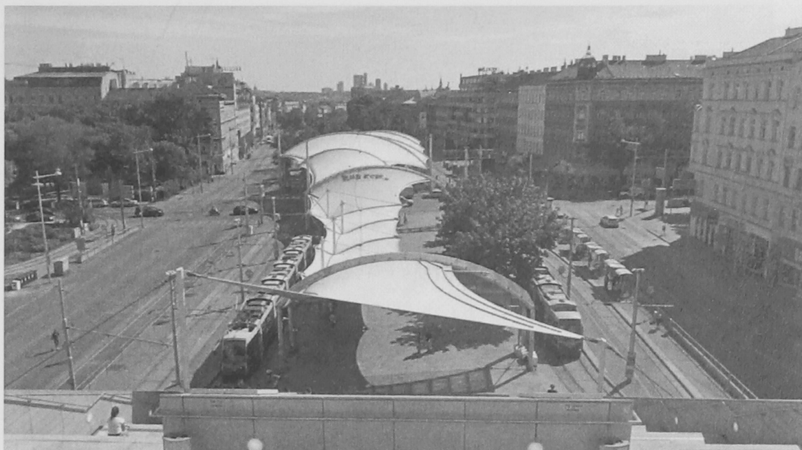
Рис. 3. Главная городская библиотека Вены над железнодорожными путями (2003)
