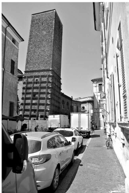
Ил. 3. Просадка грунтов. «Падающая» средневековая башня на Виа Паоло Коста в Равенне (Италия)
