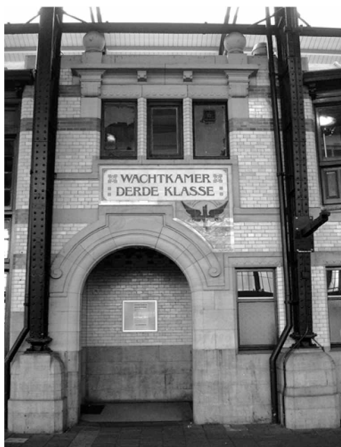
Ил. 2. Чугунные опоры перекрытия дебаркадера железнодорожного вокзала, Хаарлем (Нидерланды)
