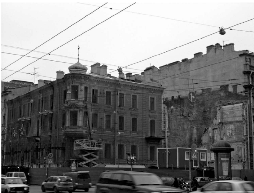
Ил. 14. Процесс реконструкции комплекса зданий гостиницы «Рэдиссон Соня». Литейный проспект, 5 / ул. Чайковского, 19, Санкт-Петербург
