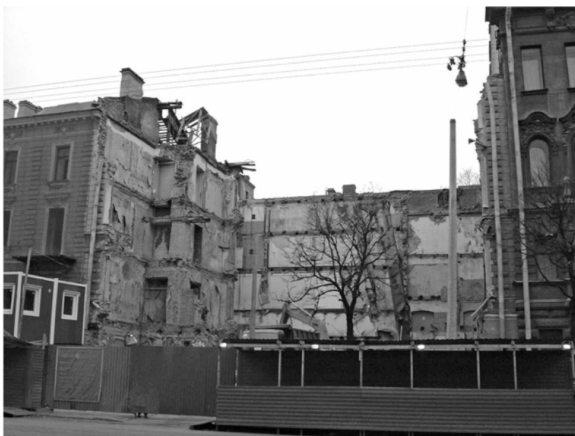
Ил. 15. Полный снос здания по ул. Чайковского. Фото А.С. Мухина. 13.01.2007
