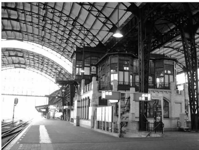
Ил. 1. Металлоконструкции дебаркадера железнодорожного вокзала, Хаарлем (Нидерланды)
