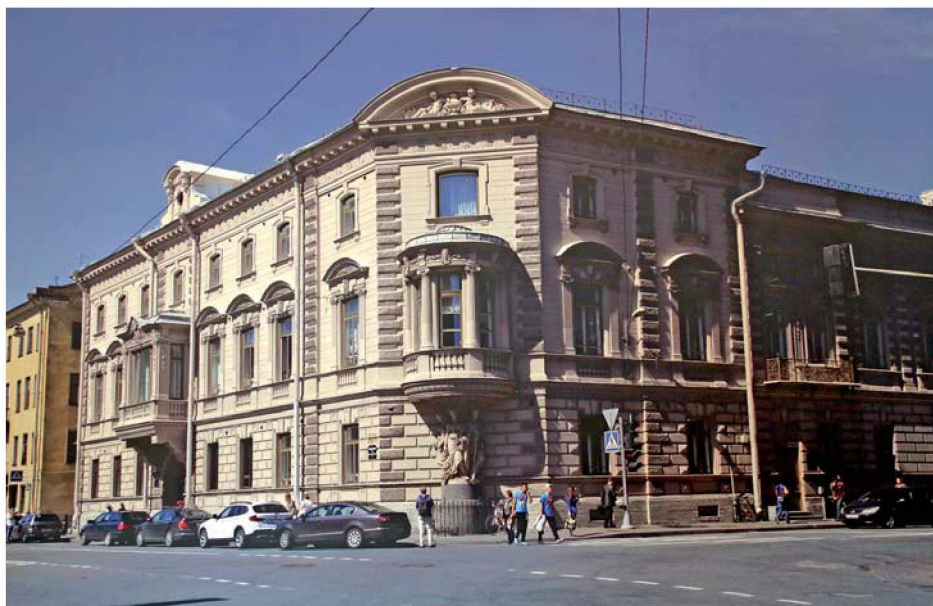
Учебный корпус на Миллионной ул., 7
