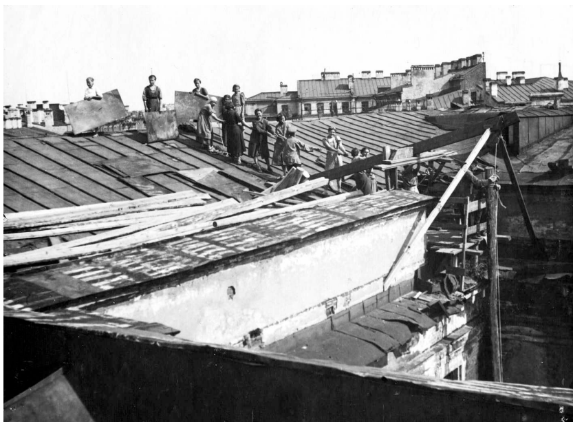
Ремонт кровли Библиотеки. Лето 1943 г.
